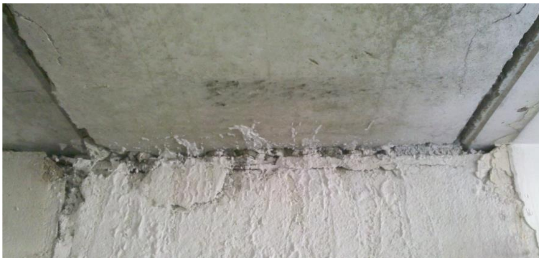
Obrázek 7.: Poškozený stěnový panel v místě uložení stropního panelu. Stav zjištěn při rekonstrukci po odstranění původního bytového jádra, T06B – KDU, Židlochovice.
