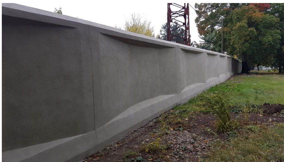
Obrázek 14.: Jižní úsek zdi po sanaci
