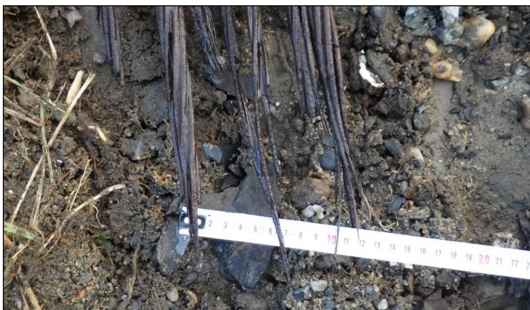
Obrázek 4.: Příklad lokálního překorodování drátů, resp. celých předpínacích lan systému B.
