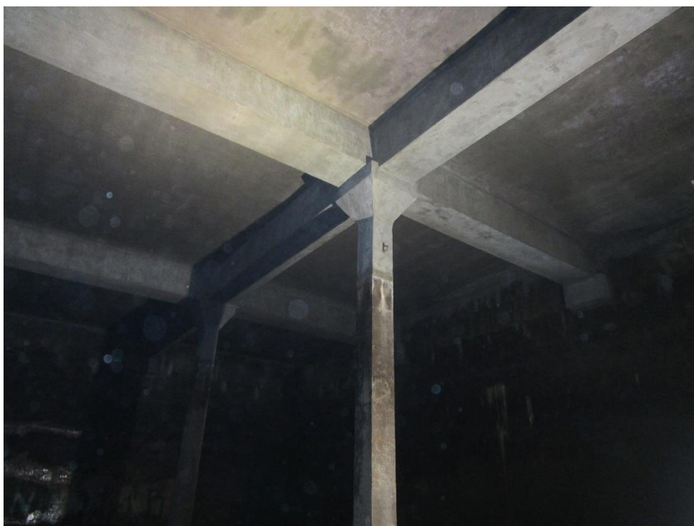
Obrázek 6: Prostor akumulční nádrže po demontáži lešení
