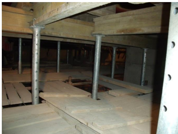
Obr.9 – Podpěrná skruž stropní desky
