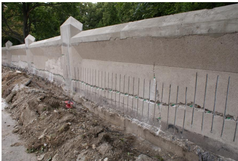
Obrázek 10.: Sešívání horizontálních trhlin helikální výztuží
