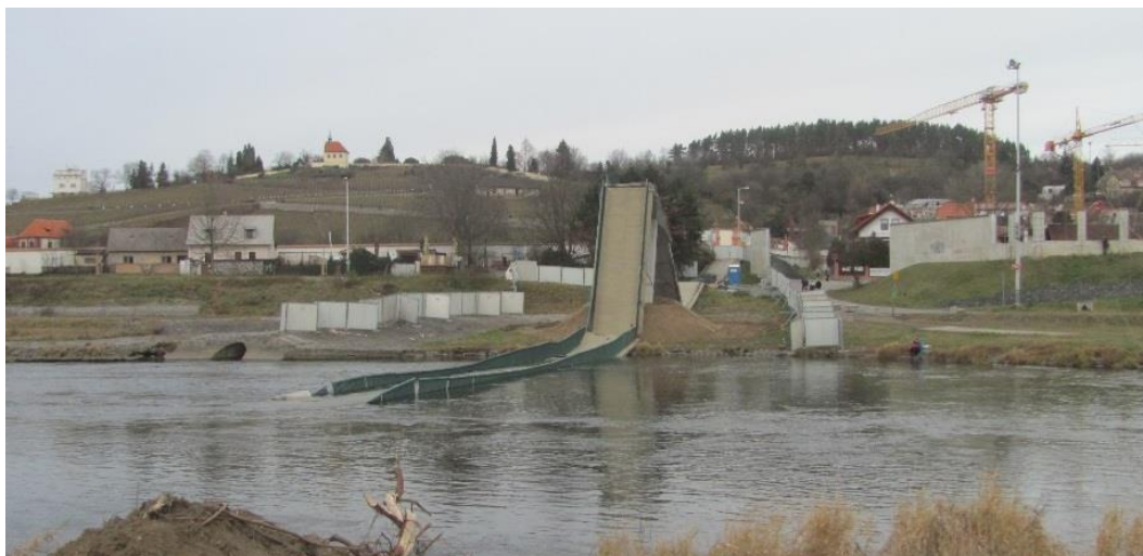
Obrázek 2.: Trojská lávka po havárii, prosinec 2017, Zdroj: archiv autora
