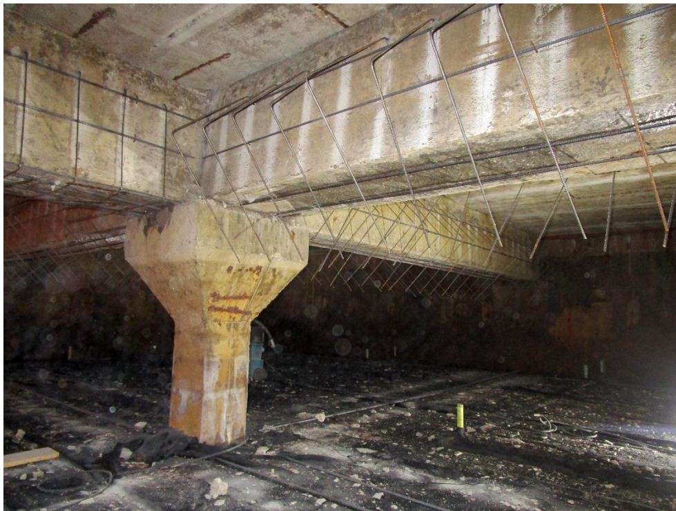
Obrázek 1.: Zesilování konstrukce přidanou výztuží
