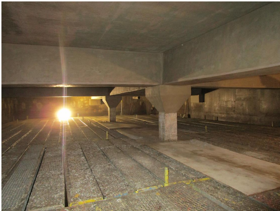
Obrázek 5.: Konstrukce po sanaci
