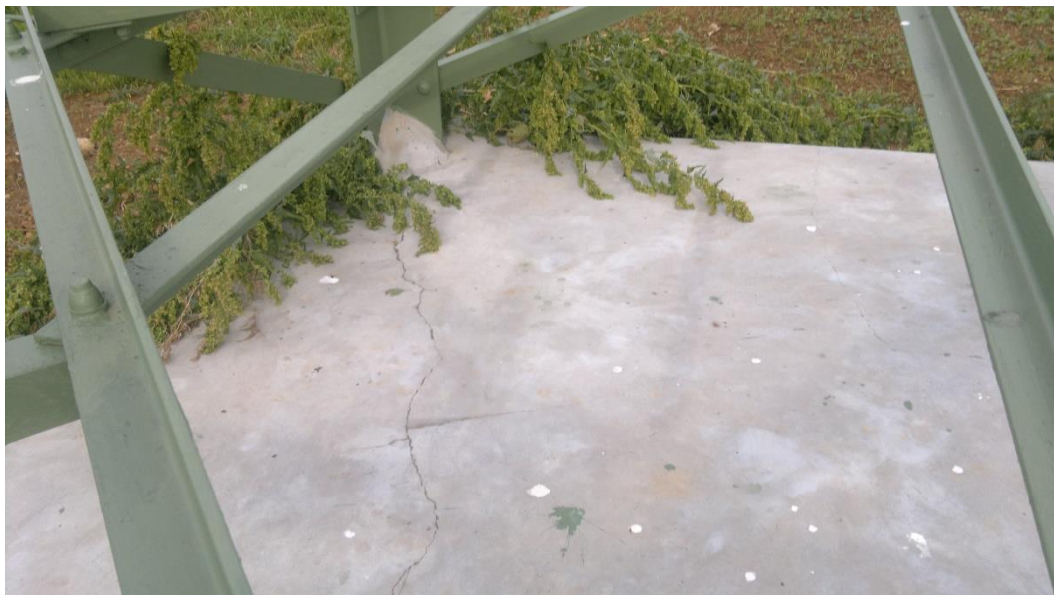
Obrázek 4.: Trhliny na patce
