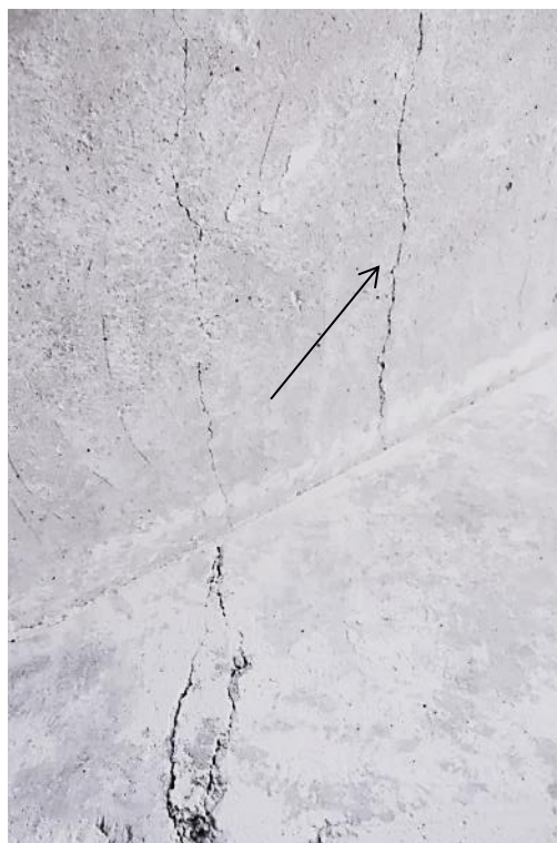
Obrázek 1.: Trhliny v rameni schodiště v panelovém bytovém domě, soustava T06B, Brno.
