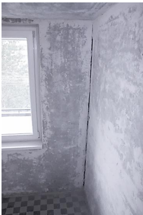
Obrázek 6.: Vlevo - nedostatečné vyplnění styku, soustava T06B, Brno. Stav objektu při rekonstrukci schodišťového prostoru (prvky jsou bez omítky). Vpravo - nedostatečné probetonování oblasti u bytového jádra, T06B – KDU, Židlochovice.
