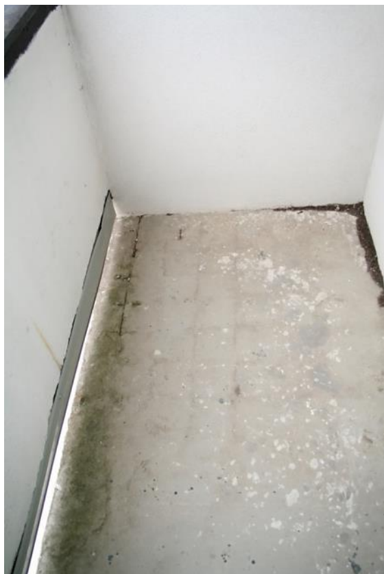
Obrázek 4.: Viditelné vyztužení v u horního povrchu lodžiovém panelu, krycí betonová vrstva je minimální nebo nulová, soustava T06B, Brno.
