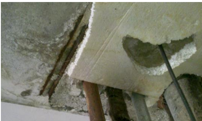
Obrázek 6.: Vlevo - nedostatečné vyplnění styku, soustava T06B, Brno. Stav objektu při rekonstrukci schodišťového prostoru (prvky jsou bez omítky). Vpravo - nedostatečné probetonování oblasti u bytového jádra, T06B – KDU, Židlochovice.
