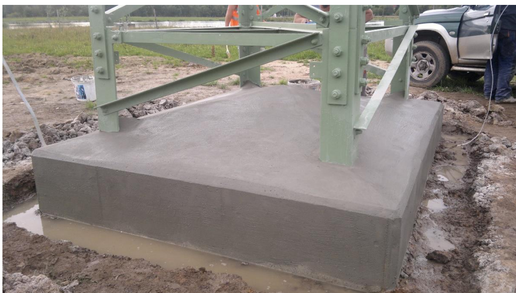
Obrázek 5.: Ošetření pomocí materiálu Xypex
