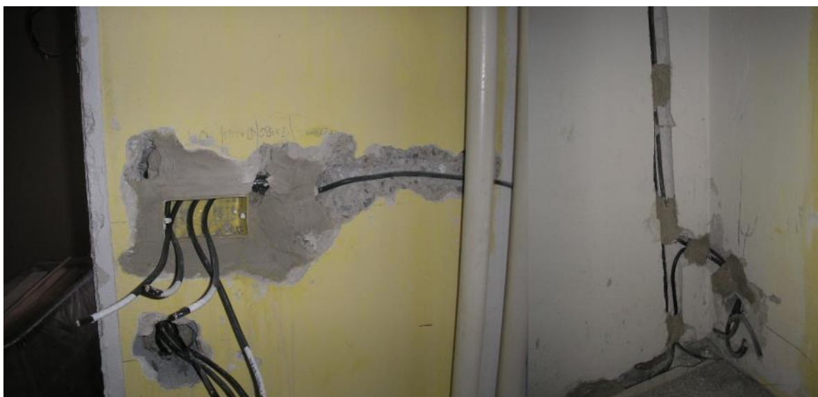
Obrázek 9.: Drážky provedené pro elektro instalaci hluboké až 40 mm v nosných stěnových panelech tloušťky 140 mm. Soustava B70/R, Brno.
