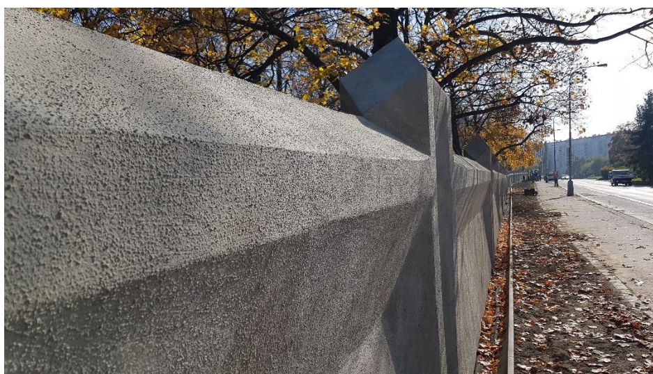
Obrázek 12.: Detail povrchu po sanaci
