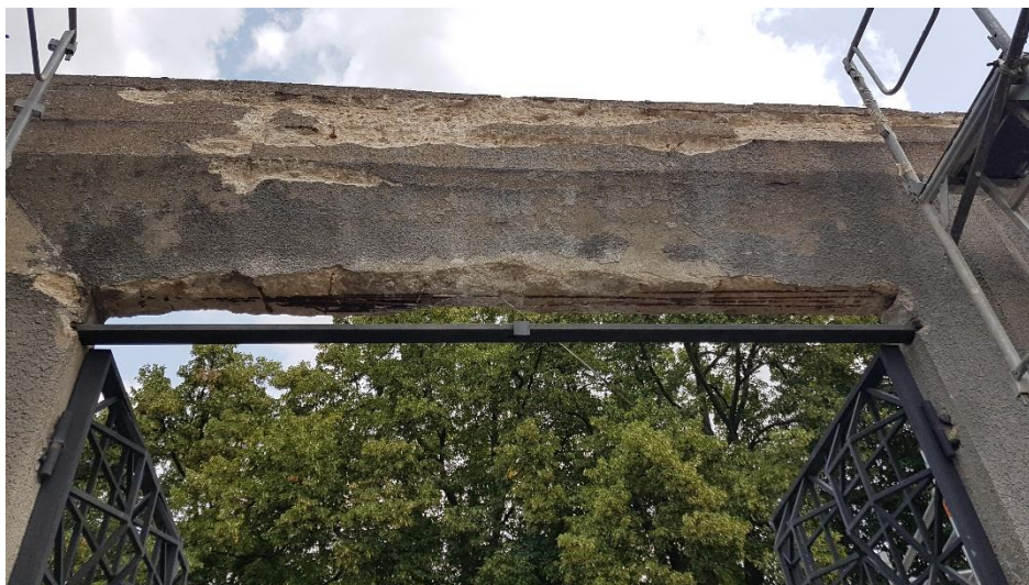
Obrázek 3.: Poškození portálu původní hlavní brány
