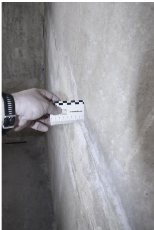
Obrázek 5.: Nepřesnost osazení jednotlivých prvků, při průzkumu zjištěny i odchylky více jak 12 mm, soustava T06B, Brno. Stav objektu při rekonstrukci schodišťového prostoru (prvky jsou bez omítky).
