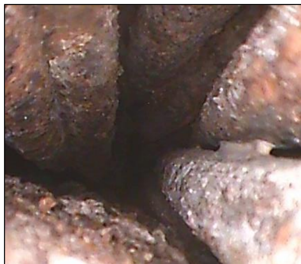
Obrázek 6.: Endoskopická fotografie stavu výztuže v dutině mezi neprobetonovanými svazky lan systému A s rozvinutou korozí Zdroj: archiv autora
