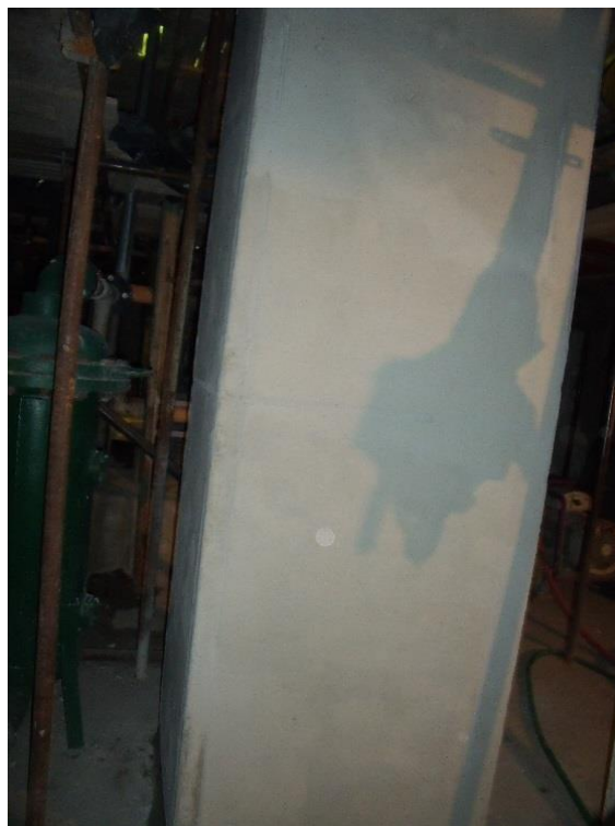
Obr. 5 – Sloup po opravě
