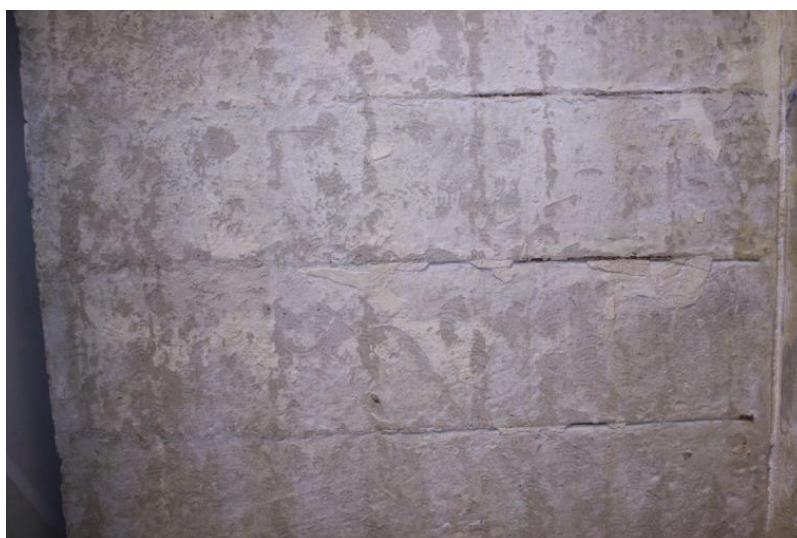
Obrázek 3.: Pohled na spodní povrch schodišťového ramene, soustava T06B, Brno.
