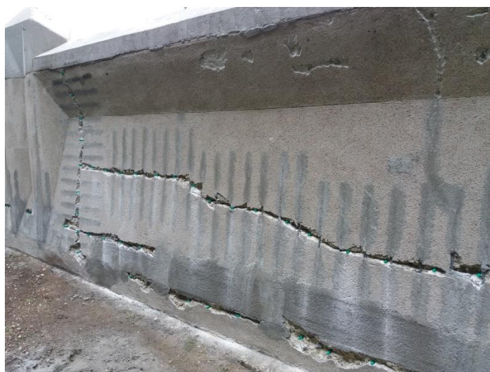
Obrázek 8.: Příprava trhliny pro injektáž, osazené pakry
