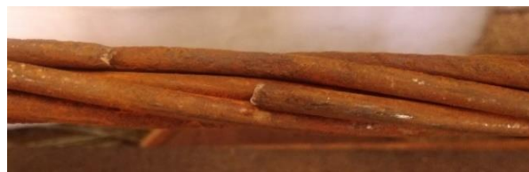
Obr. 8: Lano s relativně málo rozvinutou povrchovou korozí, lano po tahové zkoušce
