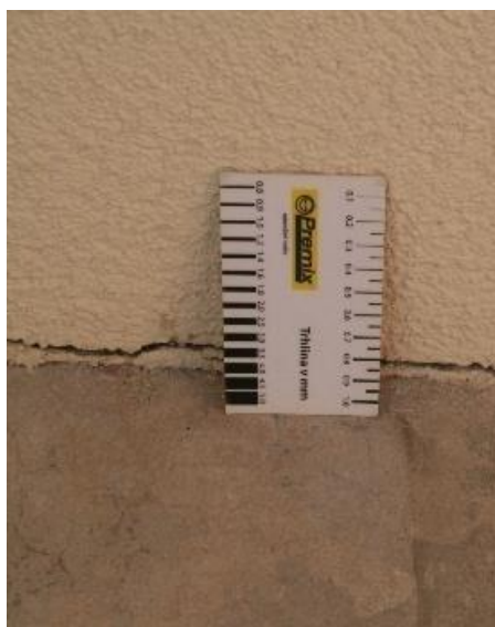
Obrázek 11.: Trhlina na styku vodorovného panelu dodatečně prováděné lodžie (druhé podlaží) a kontaktního zateplovacího systému (cca ½ rozpětí lodžie), soustava T06B-KDU, Žďár nad Sázavou.
