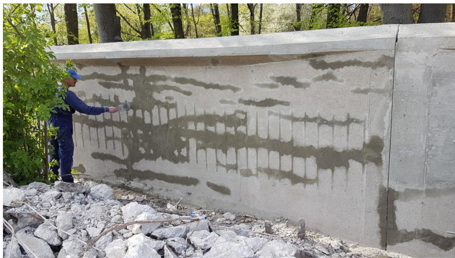
Obrázek 11.: Reprofilace betonu
