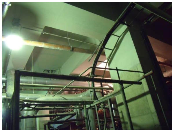
Obr. 11 – Stav před dokončením nátěrového systému
