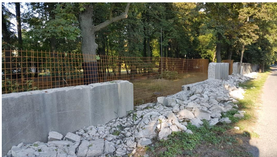
Obrázek 5.: Bourání nejvíce poškozených částí zdi
