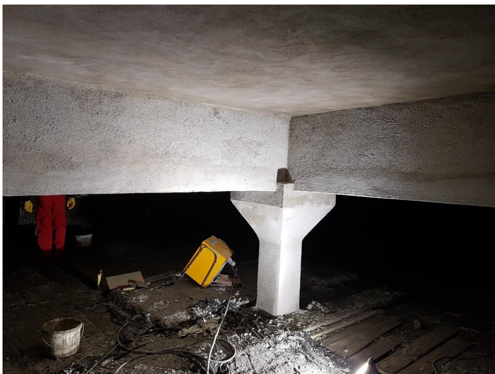
Obrázek 4.: Konstrukce po provedení hrubé sanace
