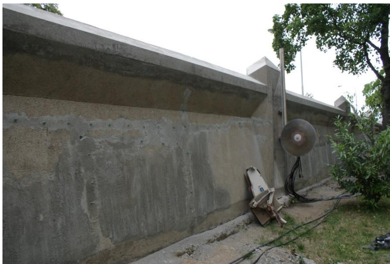
Obrázek 13.: Provádění dodatečných dilatací zdi diamantovým řezáním
