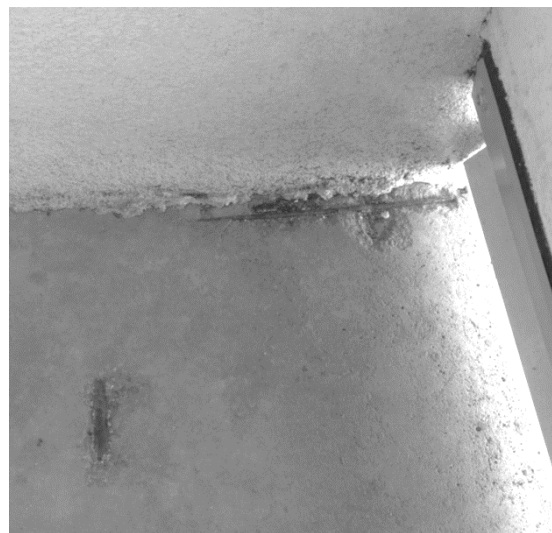
Obrázek 4.: Viditelné vyztužení v u horního povrchu lodžiovém panelu, krycí betonová vrstva je minimální nebo nulová, soustava T06B, Brno.
