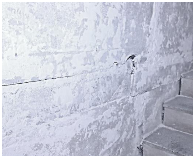
Obrázek 5.: Nepřesnost osazení jednotlivých prvků, při průzkumu zjištěny i odchylky více jak 12 mm, soustava T06B, Brno. Stav objektu při rekonstrukci schodišťového prostoru (prvky jsou bez omítky).
