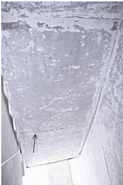
Obrázek 1.: Trhliny v rameni schodiště v panelovém bytovém domě, soustava T06B, Brno.
