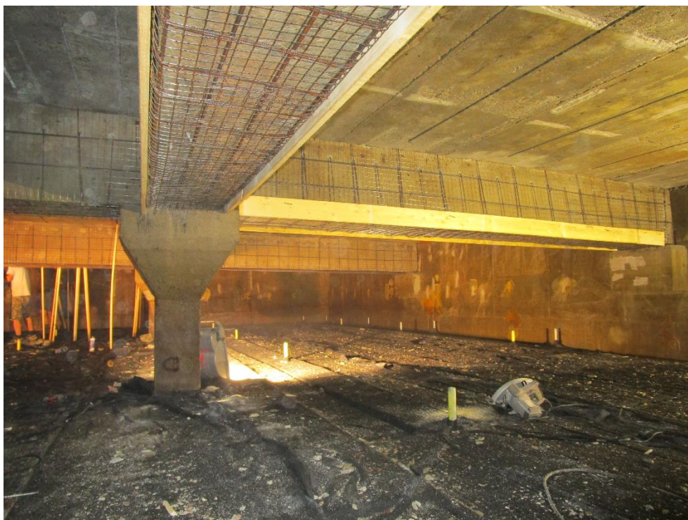
Obrázek 2.: Konstrukce před aplikací sanační malty
