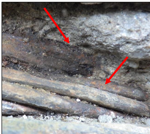
Obrázek 5.:Příklad výrazně odlišného korozního stavu předpínacích lan, uložených ve svazku těsně vedle sebe (sonda do mostovky shora) Zdroj: archiv autora
