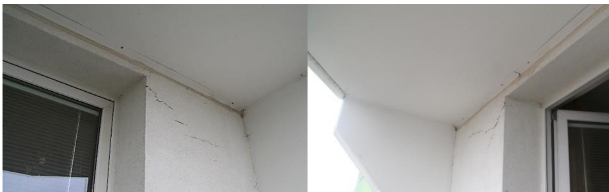
Obrázek 10.: Poškozený dodatečně prováděný kontaktní zateplovací systém. Porucha je na styku s dodatečně prováděnou železobetonovou konstrukcí lodžie, soustava T06B, Brno.
