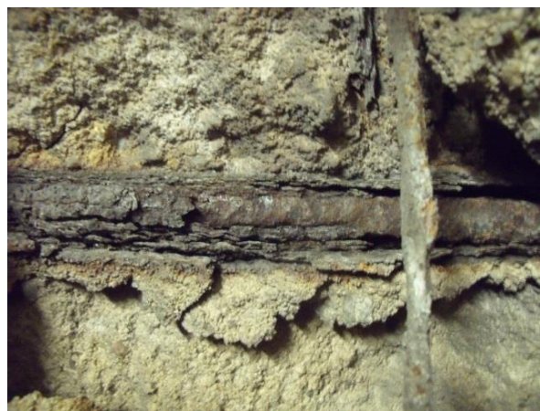
Obr. 2 – Detail korozí napadené výztuže
