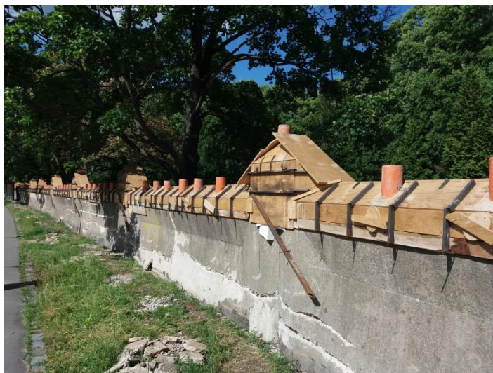
Obrázek 6.: Atypické bednění hlavy zdi
