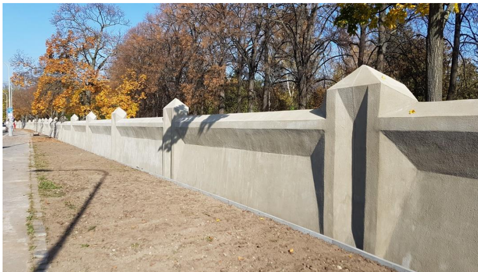
Obrázek 16.: Západní úsek zdi u ulice Ďáblické po sanaci
