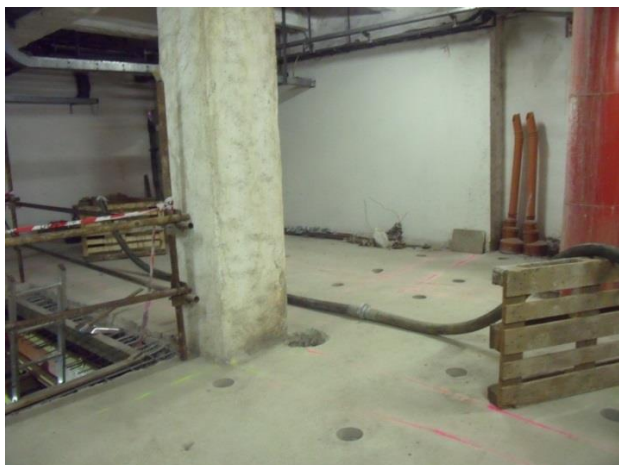
Obr. 8 – Pohled na rastr otvorů pro ukládku betonu stropní desky
