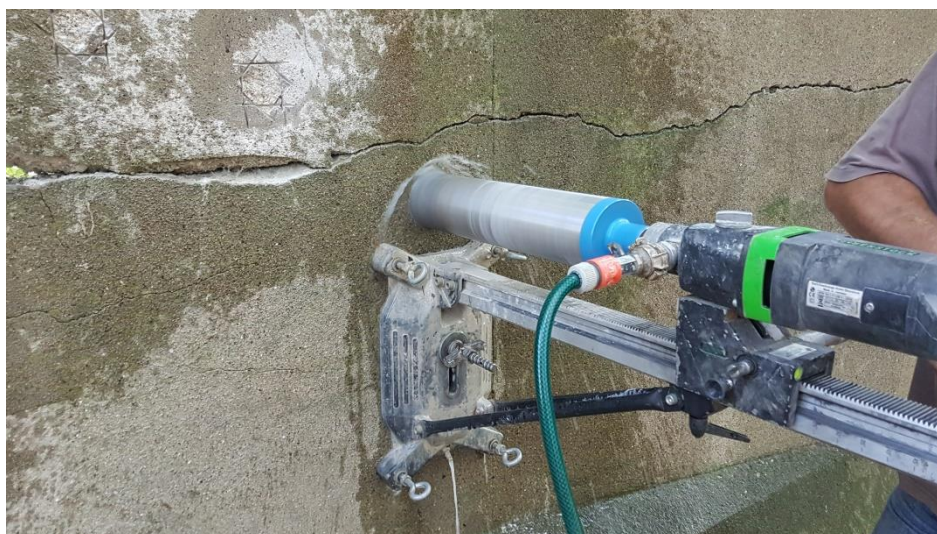
Obrázek 4.: Provádění jádrového vývrtu z původní konstrukce zdi
