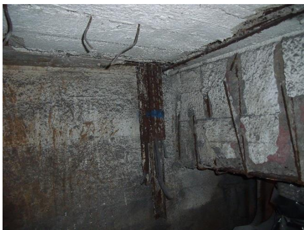
Obr. 1 – Průvlak – stav před opravou
