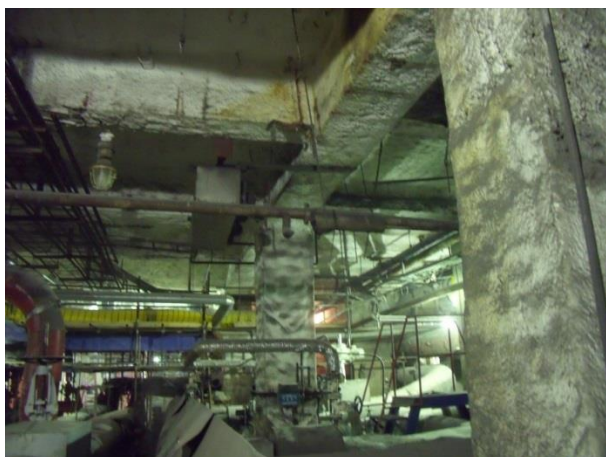
Obr. 10 – Stav před opravou
