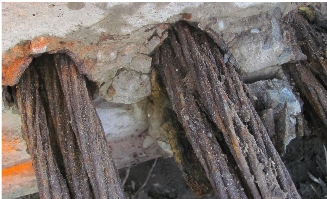
Obrázek 3.: Korozního stavu předpínacích lan systému B v desce visutého pásu lávky, železobetonový prefabrikát poškozený pádem, nezainjektované kanálky.
