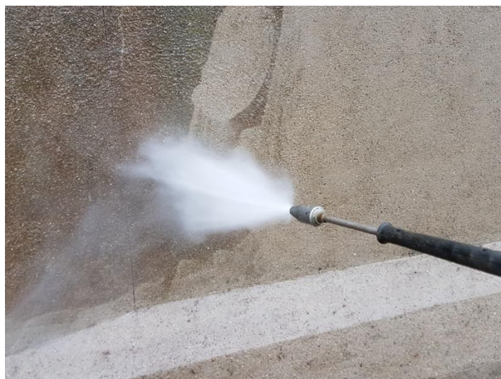
Obrázek 9.: Čištění povrchu konstrukce, tryskání povrchu před sanací
