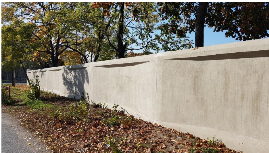
Obrázek 17.: Jižní úsek zdi po sanaci
