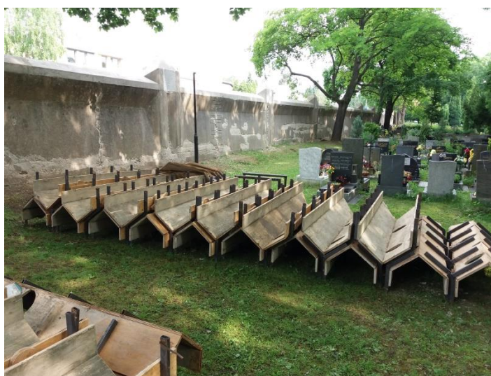
Obrázek 7.: Složené bednění na hlavu zdi
