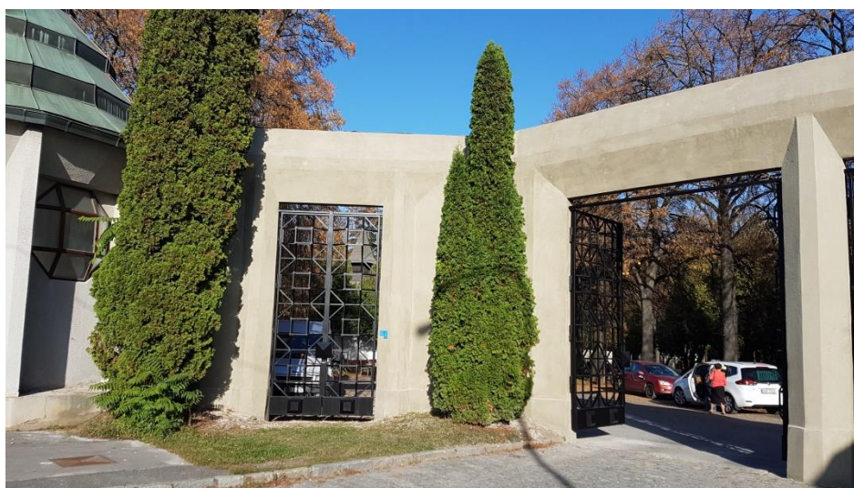
Obrázek 15.: Hlavní vstup po sanaci
